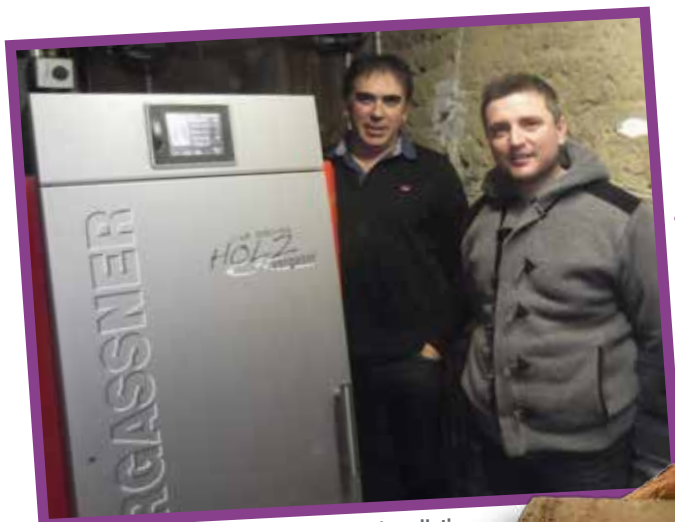
M. Flachon et son installateur ravis de l'installation.
