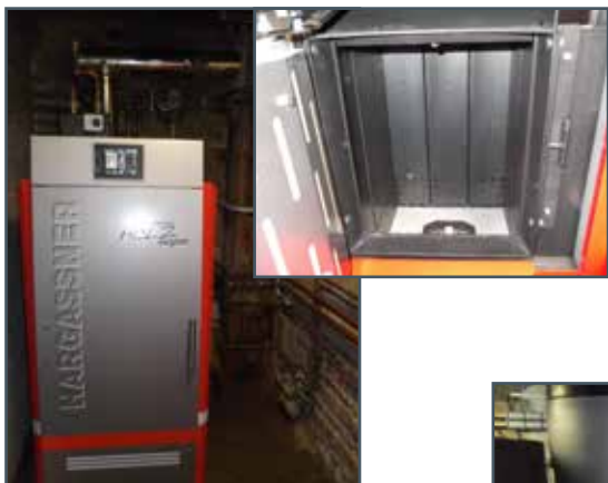
Chargement manuel des bûches : grand volume de chargement de 166 litres.
