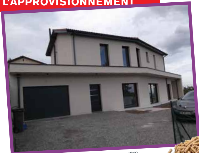
Résidence principale sur 2 étages - Chaussan (69)
