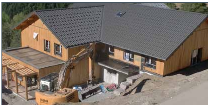
Construction du pôle enfance site Bois de l'Ours - 2016
