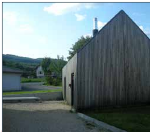
Chaufferie indépendante de 20 m 2 et vue sur la trappe de remplissage Containergie
