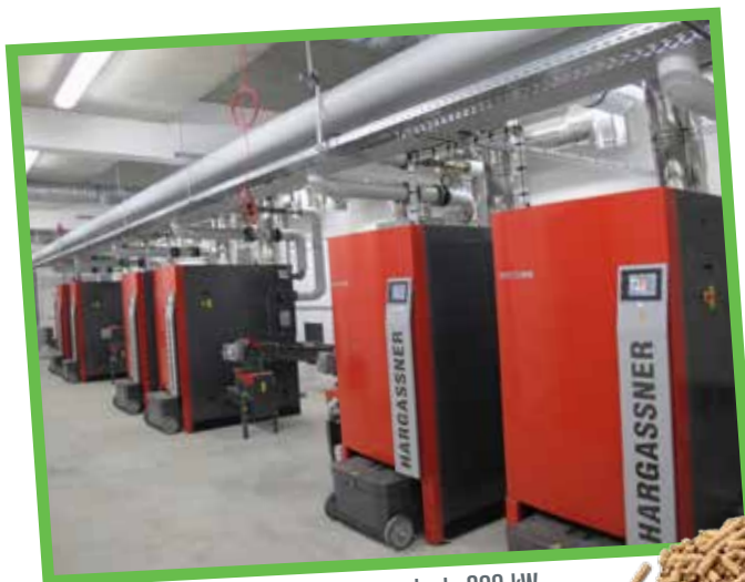
Chaufferie avec 6 chaudières en cascade de 200 kW
