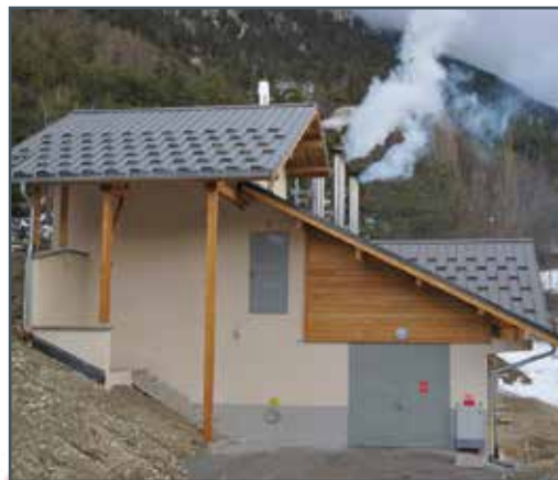
Chaufferie indépendante de 242 m 2
